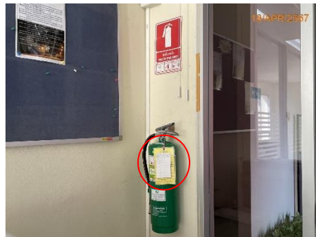
ภาพที่ 2.2-41 การตรวจสอบสภาพอุปกรณ์ดับเพลิงโดยบริษัทผู้จำหน่าย
