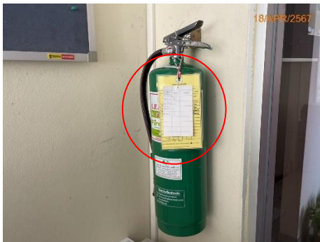
ภาพที่ 2.2-41 การตรวจสอบสภาพอุปกรณ์ดับเพลิงโดยบริษัทผู้จำหน่าย
